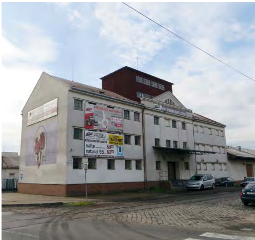
Současná podoba budovy bývalého Hospodářského družstva
